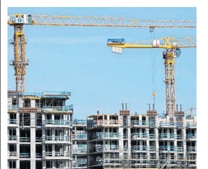
Kräne stehen auf einer Baustelle für Wohnhäuser in Hamburg. BILD: DPA
